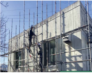
外壁補修工の様子
