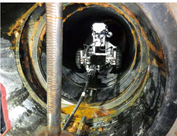
八千代幹線(下流側)の調査状況
