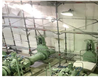
内部防音工の様子
