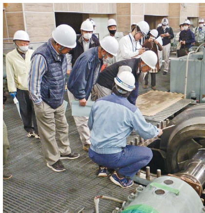
ポンプ内部の劣化状況確認
