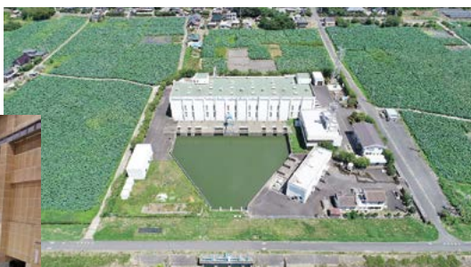
霞ヶ浦揚水機場外観(写真中央の建物)
