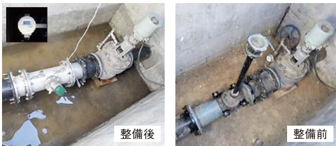
工 事 名：令和5年度 観音川支線4号 8-1分水工 定流量弁部品交換整備及び流量計更新 場 所：筑西市三郷地内 分水工設備：可変定流量弁 φ250mm×1台 電磁流量計 φ250mm×1台 事 業 費：3,102千円
