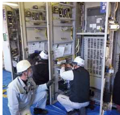
電気設備工事の様子
